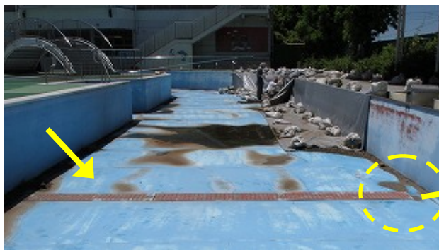
図 8 循環ろ過用の取水ます
